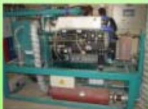
Le bloc **BHKW** (**Block**heiz**kraft**werk**) ou groupe de cogénération, produit de l'électricité et de la chaleur à partir du biogaz (méthane).******
