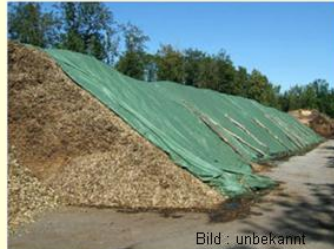
Cellule de stockage du bois déchiqueté
