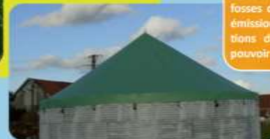
Couverture sur fosse à lisier
